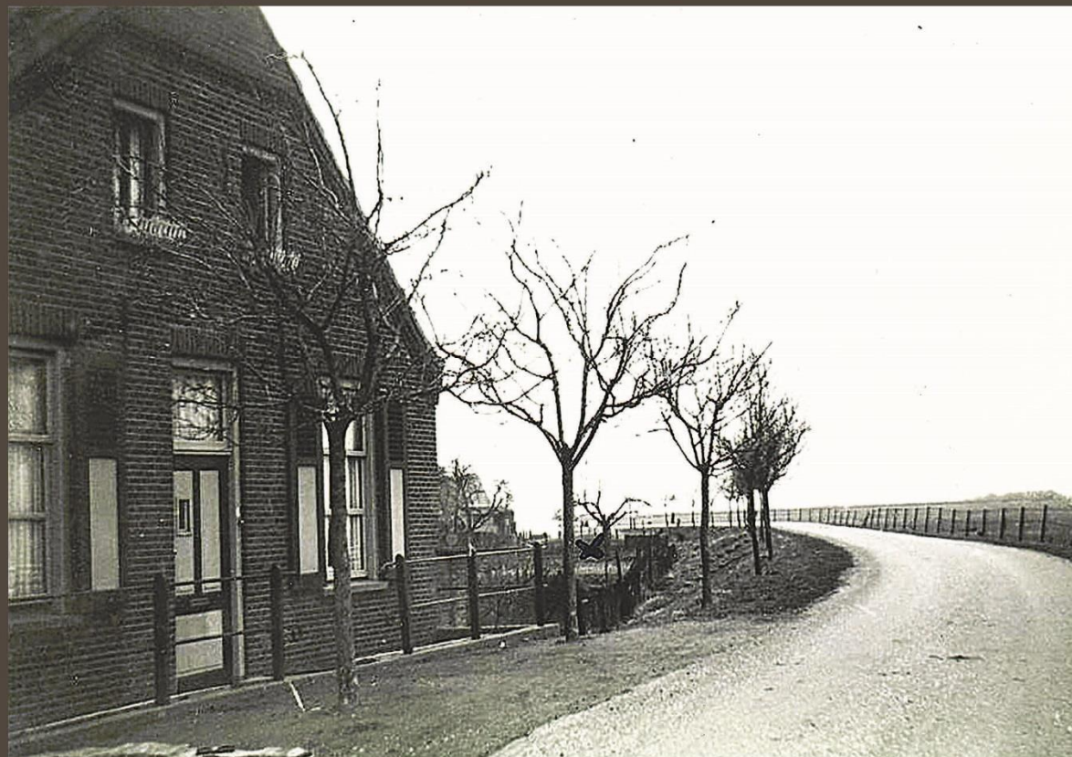
Dit pand uit 1852 was aanvankelijk een bijgebouw van de bierbrouwerij aan de Paterstraat (nu Kloosterstraat). Begin 20e eeuw is het door aannemer Sjaak van Rooy verbouwd tot woonhuis en ook door hem bewoond geweest. In 1935 werd het verkocht aan Thé van Orsouw, palingvisser op de Maas.
