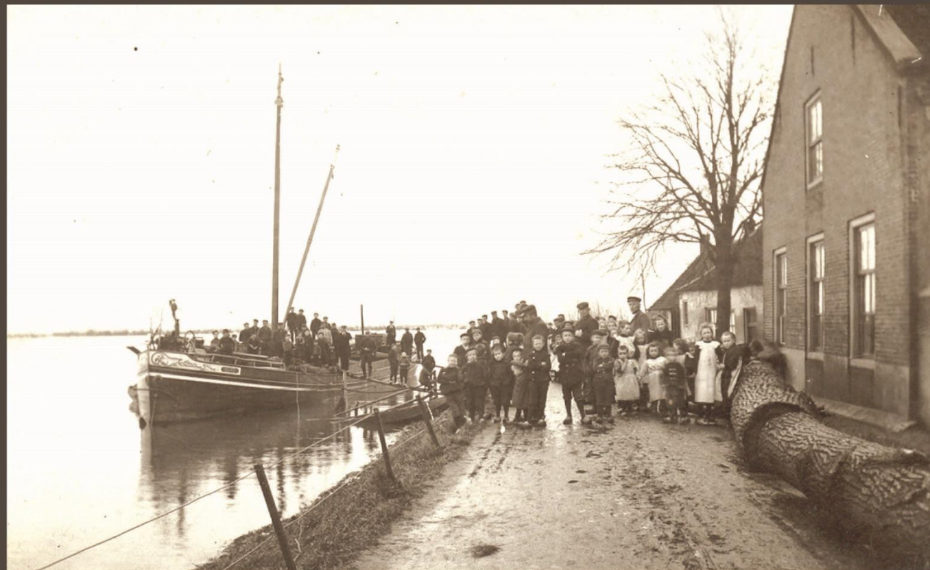
Vlakbij het veer was een sluis. In 1909 brak deze door. De uiterwaarde werd één grote watervlakte, waardoor dit schip zo dichtbij kon komen. De overstroming was bijzonder triest, omdat veel mensen bij de jaarlijkse grasverpachtingen daardoor grote schade ondervonden.
