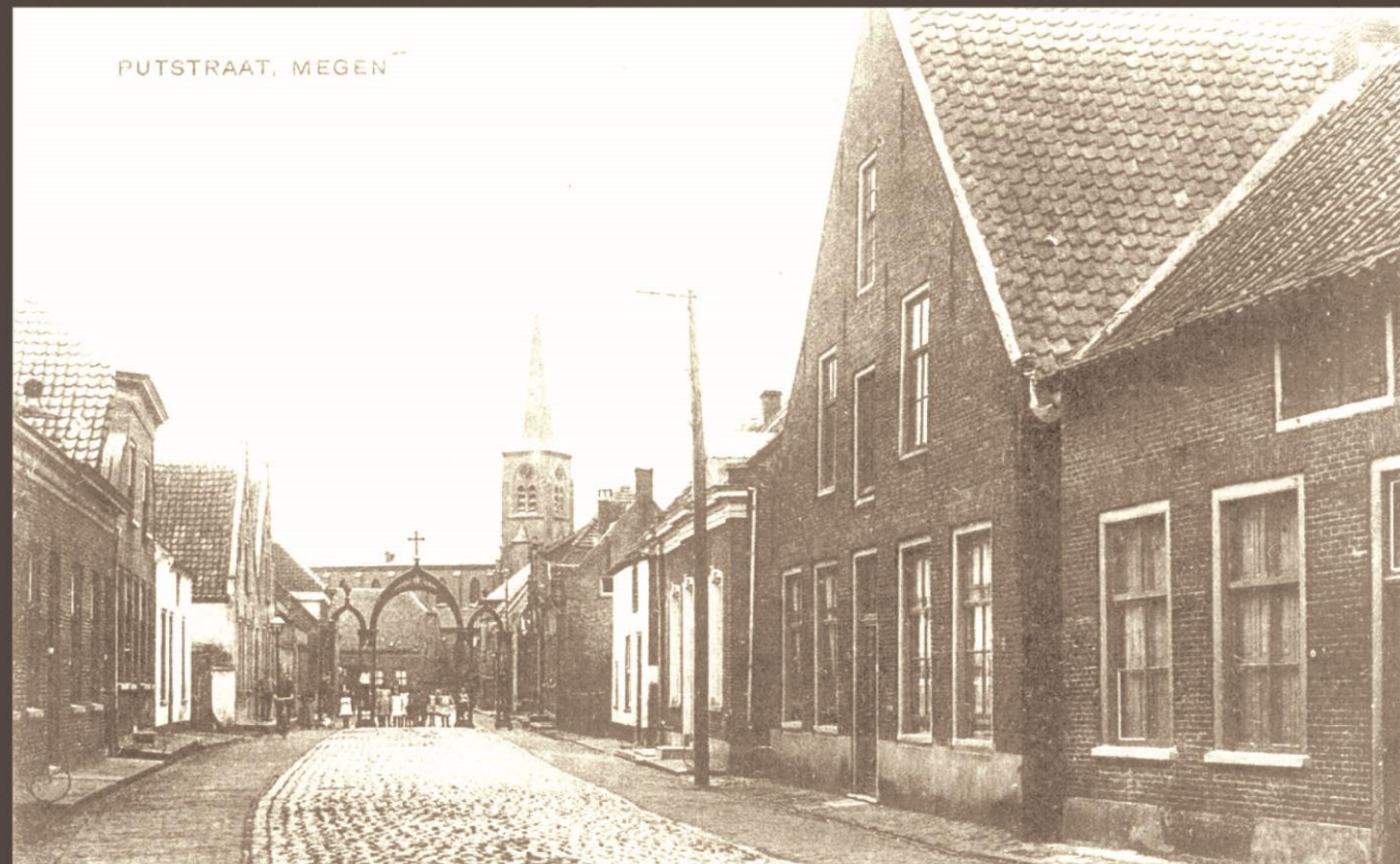
Dit pand werd in het jaar 1878 op een veiling gekocht door aannemer van Rooij. Het pand is sindsdien eigendom van de familie gebleven en in 2016 herbouwd. Het huis links (nr.23) was voorheen boerderij, kosthuis en later vestigde zich hier een architectenbureau.
