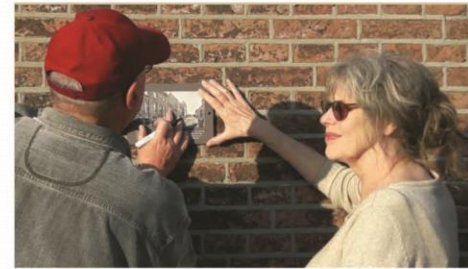
Paula assisteert Ed bij het vaststellen van de plek waar de boor in de voeg gaat Foto: WJS 300321
